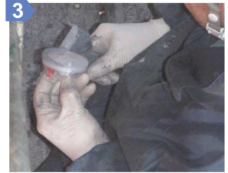
【マウスインジェクタを接着】 エポキシパテを混練し、マウスインジェクタの外周部に盛り上げる様に練りつける。コンクリート面に貼り付け圧着させる。パテが注入口のひび割れをふさがらない様に作業する。
