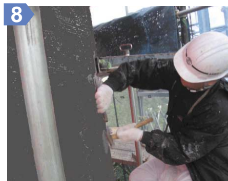
【仕上げ】 樹脂が硬化した後、マウスインジェクタを皮スキ等を用いて、除去する。
