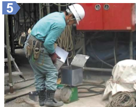
【樹脂の計量】 樹脂は、可使用時間を考慮し、可使用時間内に使い切る量を量り、十分に混合する。
