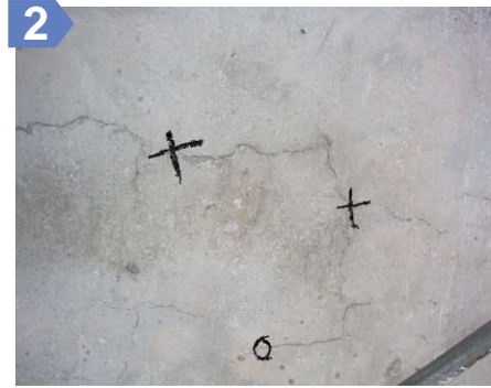
【注入口の位置決定】 定規を使って、注入口の位置を決定する。 200mm～300mm間隔。
