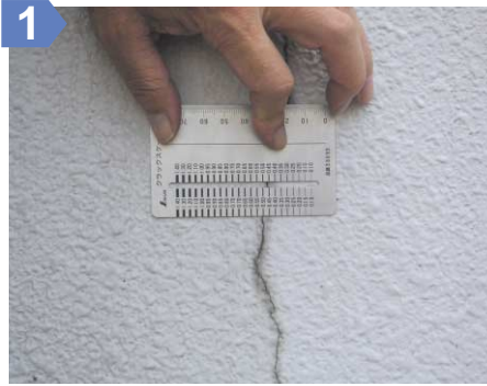
【ひび割れの調査】 ひび割れの位置、幅、深さを調査する。
