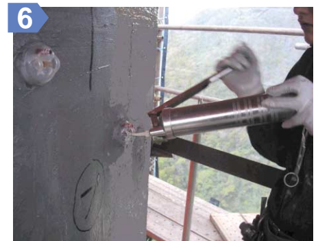
【注入】 混合した樹脂を注入器に充填し、マウスインジェクタに注入する。赤い計量バーが飛び出し、ガイド窓迄膨らんだら、一時注入を中止する。
