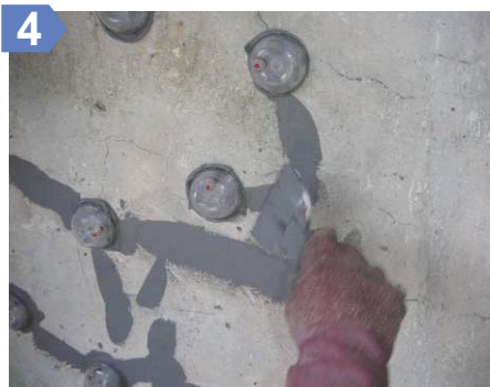
【シール】 ひび割れの表面と、マウスインジェクタの周りを確実に目止めシールする。
