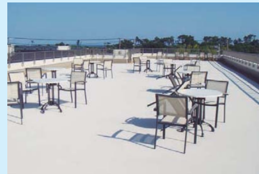
老人ホーム屋上
