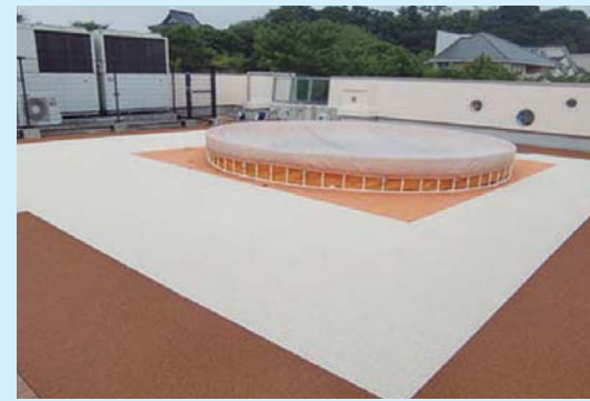
保育園・幼稚園 屋上プール
