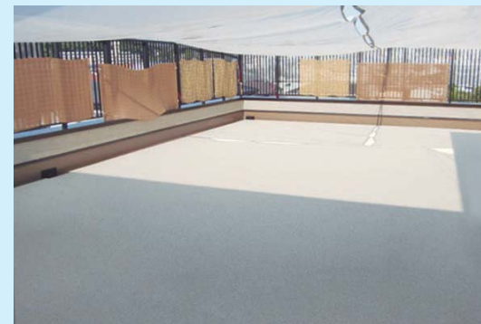
保育園・幼稚園 屋上プール
